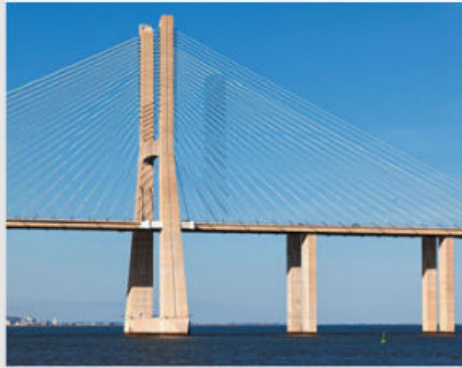
Figura 2.26. Los tensores de los puentes atirantados están hechos de acero.
