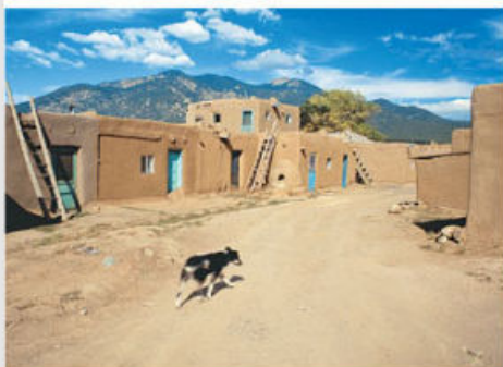
Figura 5.23. Casas mexicanas construidas con adobe, material que se usa principalmente en el norte del país.
