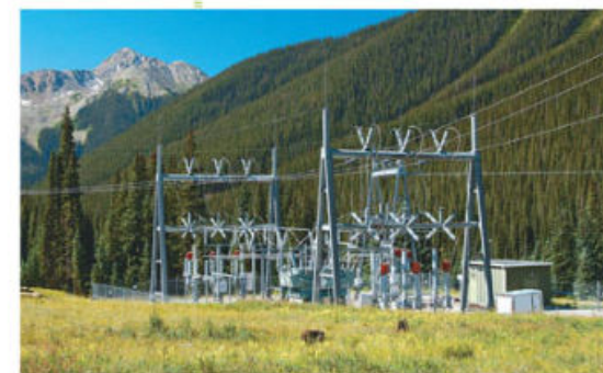
Figura 4.25. Cuando existe mal funcionamiento de los convertidores eléctricos, la energía se escapa produciendo un oxidante muy poderoso llamado ozono ( O_3 ). ¿Sabes qué reacción se lleva a cabo?
